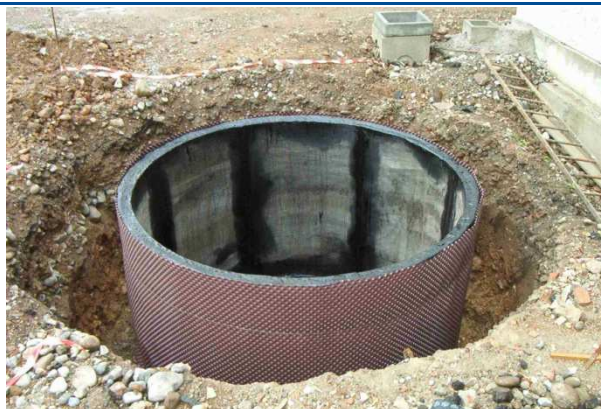
Figura 0.3 Dettaglio vasca stagna raccolta percolato pressa
