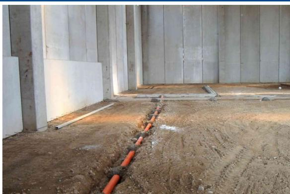
Figura 6.2 Dettaglio griglia pressa + canalizzazione alla vasca stagna
