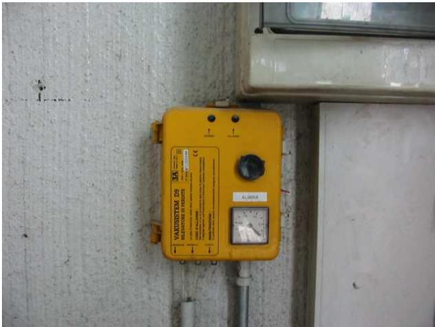
**Figura 5.3 Sistema monitoraggio tenuta e allarme**
